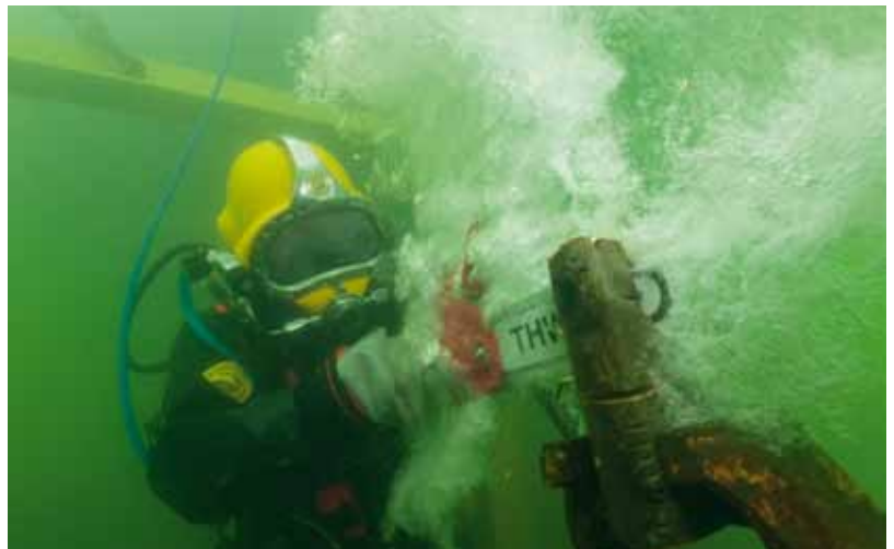
Abb. 2: Bergungstaucher des THW mit Unterwasserkettensäge
